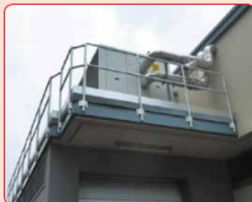
• Esempio di parapetto montato su edificio
