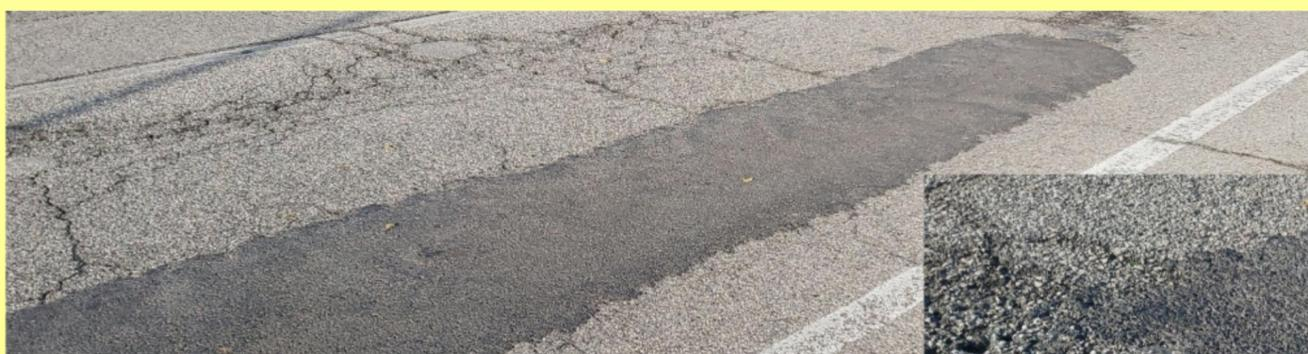
Rapidcold® a prova della sua ALTA RESISTENZA si dimostra idoneo ad APPLICAZIONI IN STRATO SOTTILE a ripresa di avvallamenti anche piccoli e riparazione di fondi fessurati senza necessità di essere messo in opera su una buca di contenimento SPESSORE MINIMO 4 mm
